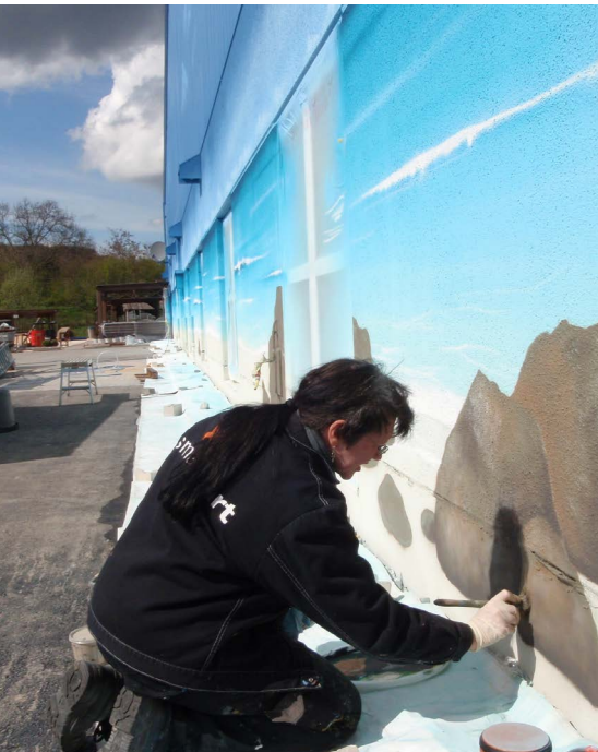
Detailarbeiten vor Ort
