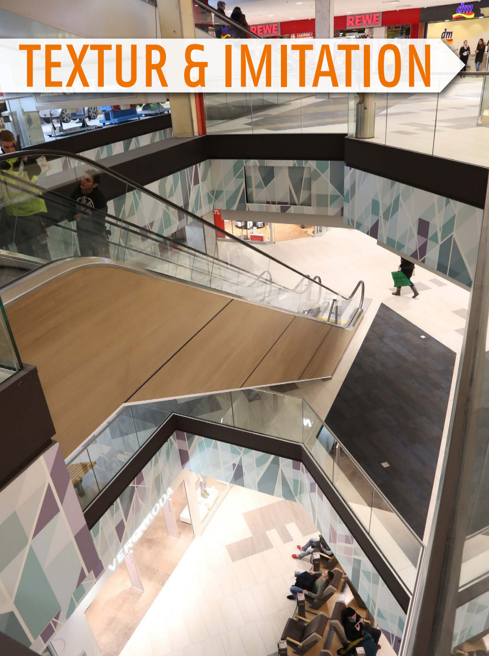
Rolltreppenverkleidung in gemalter Holzoptik Löhr-Center, Koblenz
