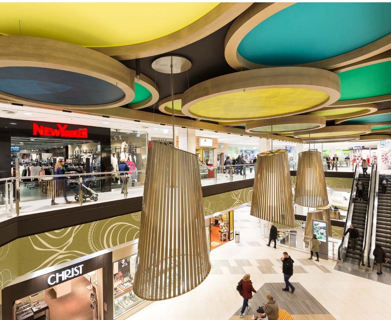
Gemalte Holzimitation auf GK-Decke und runden Aluminium Lampenrahmen Löhr-Center, Koblenz
